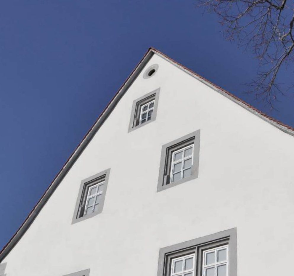
Ortgang mit Zahnleiste und Windbrett
