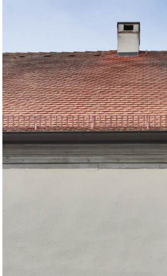
Profiliertes Traufgesims
